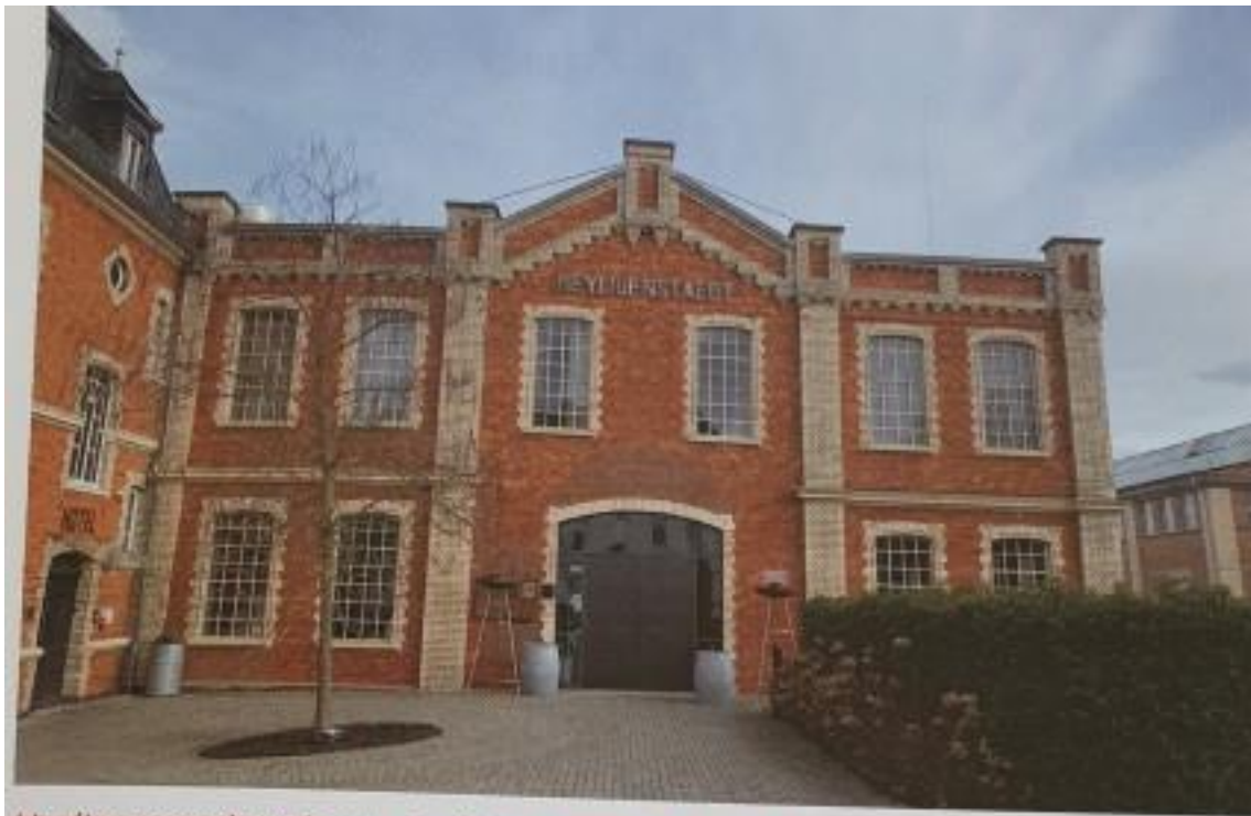
Heyligenstaedt ist heute ein Restaurant und Hotel.
